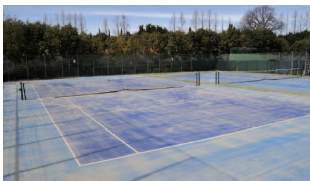
標準オムニコート(PP)を使用し、コート内外でブルーの濃度を変えたツートンカラーで仕上げました。全豪オープン会場をイメージしたカラーリングに仕上げ、ボールの視認性も向上しています。
